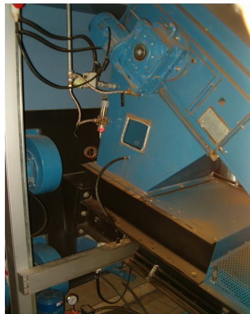
Image 6 : Amenée de bois du silo à la chaudière. Fenêtre donnant accès au combustible juste avant son entrée dans la chaudière (lieu d'échantillonnage des plaquettes de Lullier).
